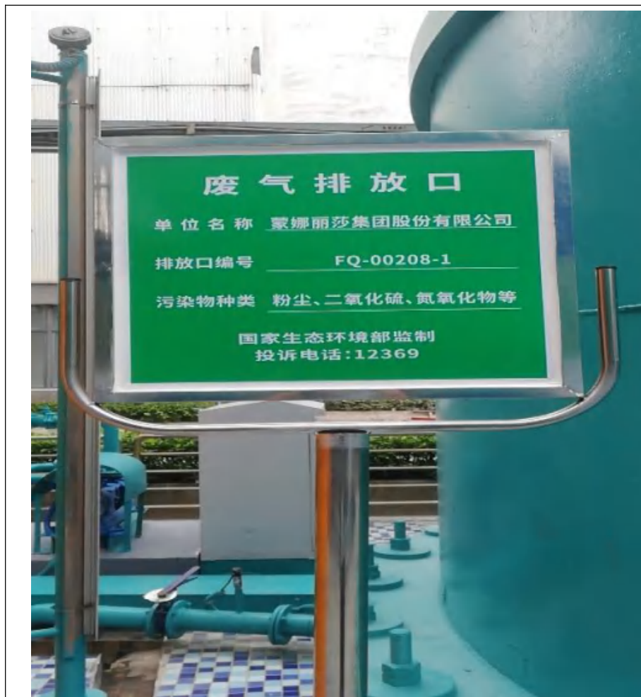
1#排气筒废气排放源
