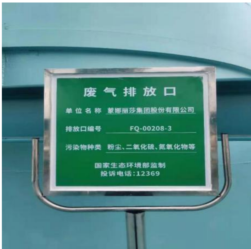
3#排气筒废气排放源
